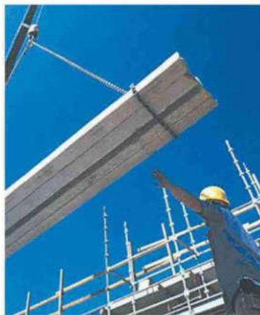
Edilizia in calo del 13% nell'ultimo anno
